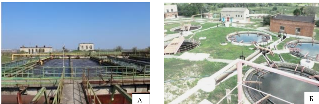
Рис. 4.33. Очистные сооружения: А - Аэротенк в г. Губкине, Б - МУП Водоканал г. Валуйки
